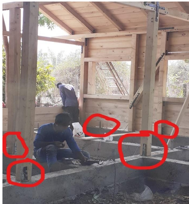
En ésta foto pueden observar claramente que los ángulos de solera se encuentran en diferentes posiciones, dependiendo de la intencionalidad para imprimir ó suprimir el esfuerzo de movimiento al culmo. La colocación depende de si las columnas de carga llevan o no cadena o trabe de cerramiento en la parte superior.
